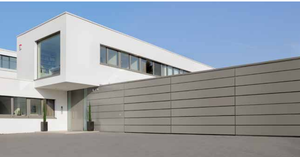
Opláštění hliníkovými sendvičovými deskami v místě stavby
