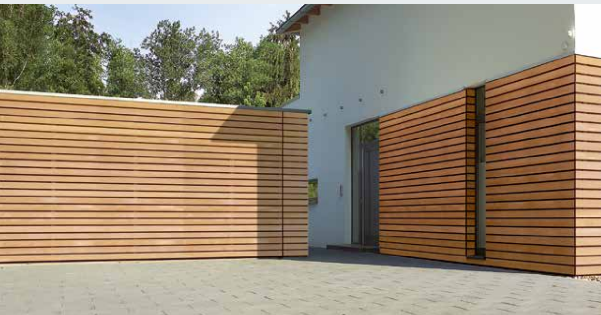
Opláštění dřevěnými panely v místě stavby
